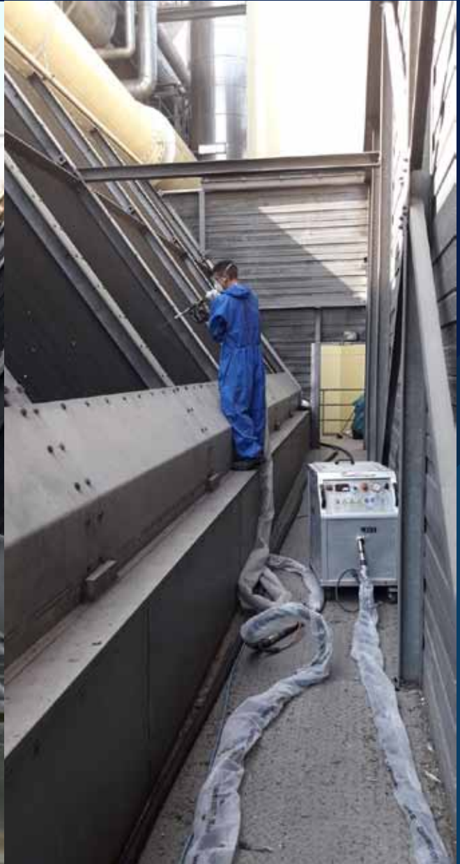
Wärmetauscherflächenreinigung mittels Trockeneisstrahlverfahren in einem Kraftwerk.
