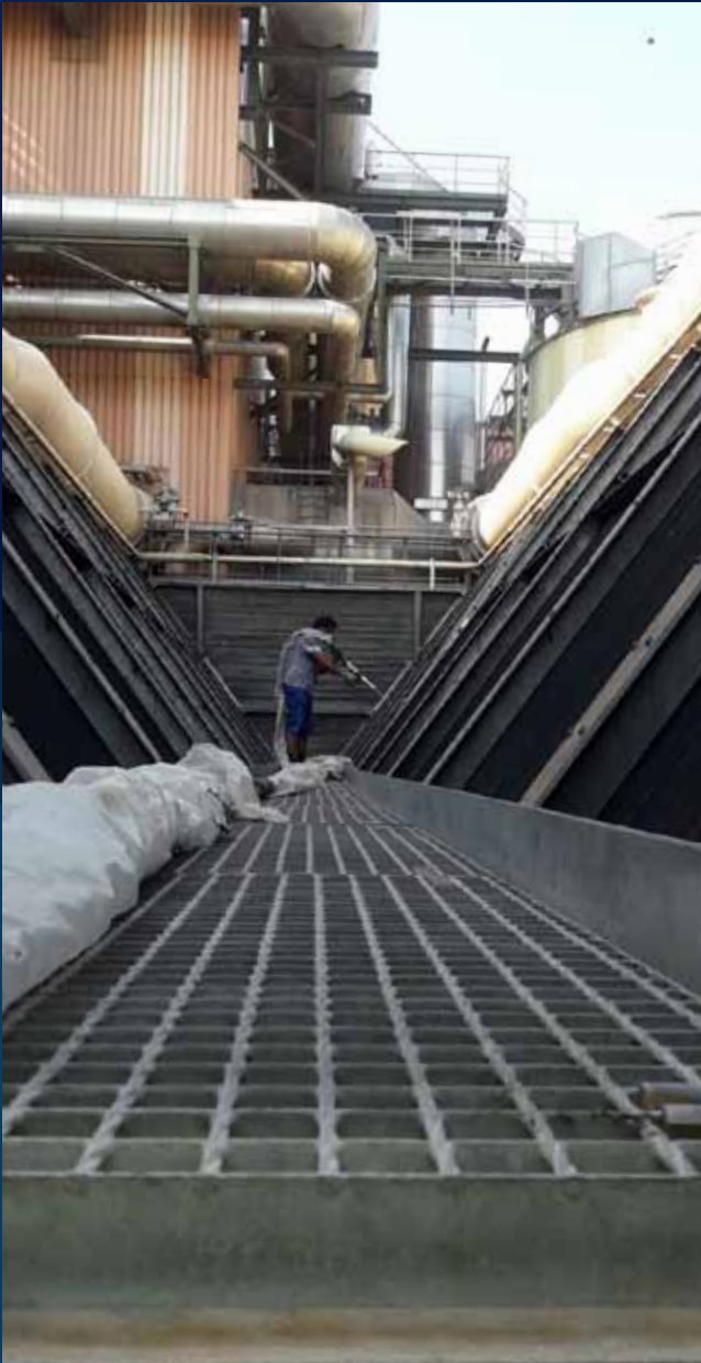
Wärmetauscherflächenreinigung mittels Trockeneisstrahlverfahren in einem Kraftwerk.
