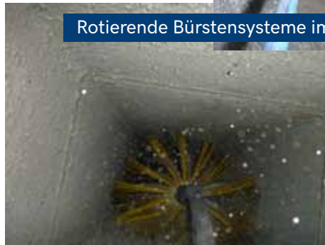
Sanierung von Luftleitungssystemen.
