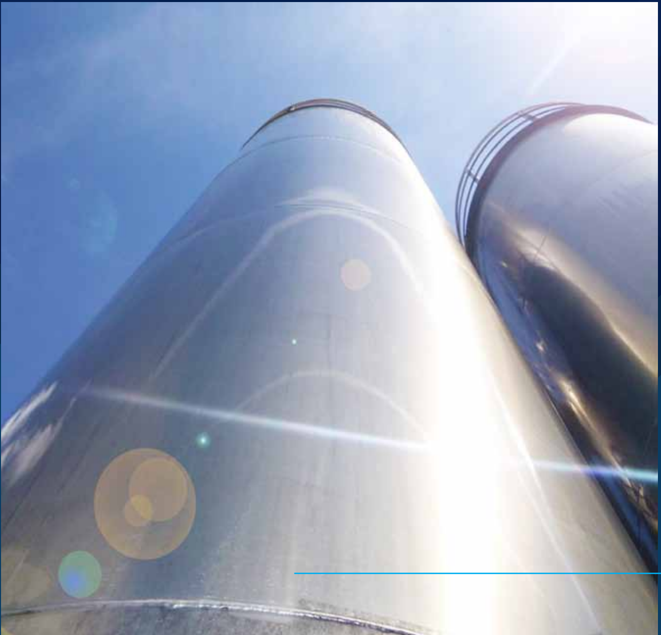
Siloreinigung mittels Trockeneisstrahlverfahren.
